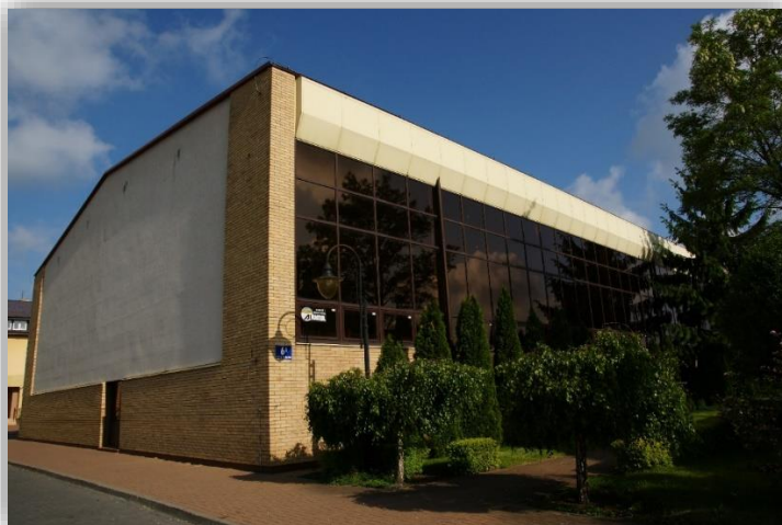
Rysunek 4. Budynek Hali Sportowo – Widowiskowej w Baboszewie.
